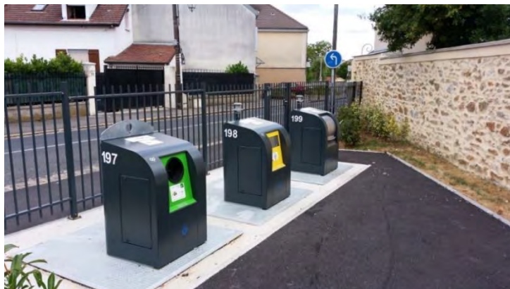
Image 12 - De gauche à droite : colonnes enterrées pour le verre, les emballages et papiers et les ordures ménagères
